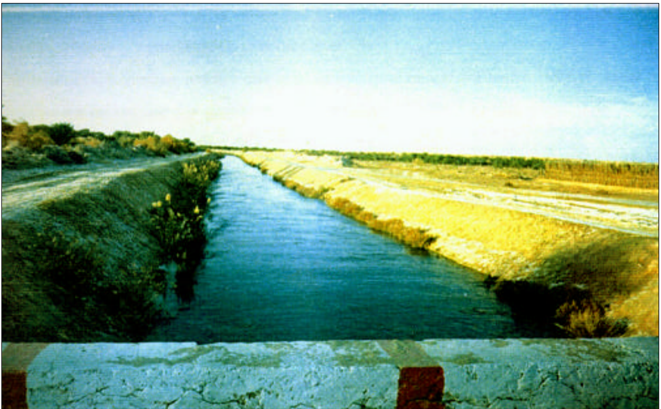
Figure n°37 : Vue du canal-drain de l'Oued Rhir
